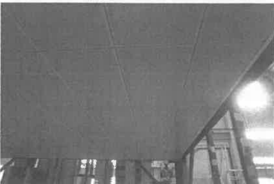
Photo B.15 시험 후 천장재 측면부 & Molding
