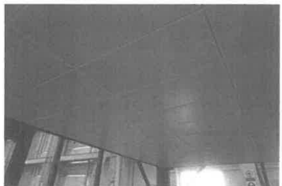
Photo B.14 시험 후 천장재 하부
